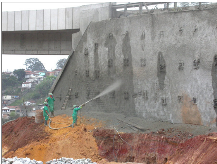
Figura 2.1 – Modelo de lançamento de concreto projetado
